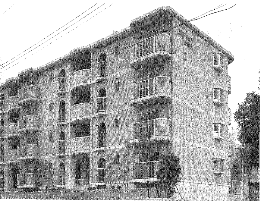
木内コンホーム
