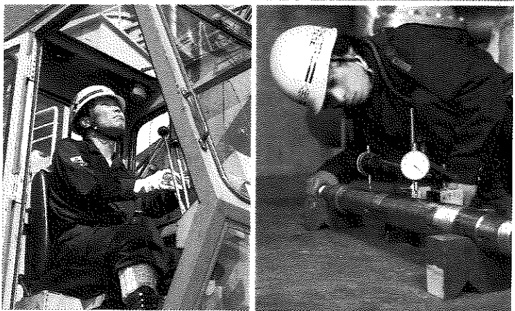
工事作業現場
