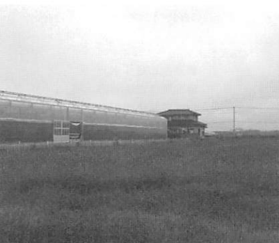
野菜工場の奥には津波被害を受け無人となった廃屋が残っている
