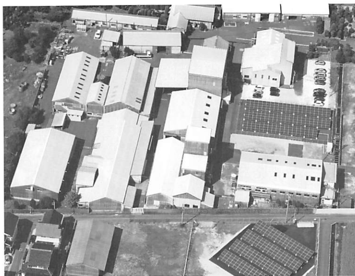
太陽光発電を設置した工場
