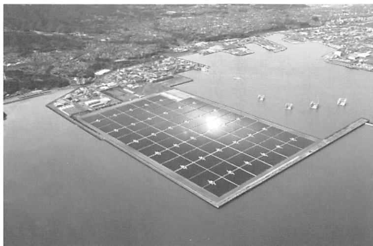
建設中の鹿児島七ツ島メガソーラー発電所(完成イメージ図) 京セラの太陽電池モジュールが使われている。
