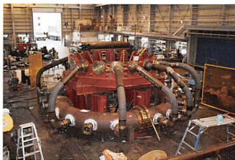
ガスタービン用配管製作
