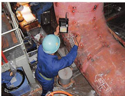
配管経年変化調査
